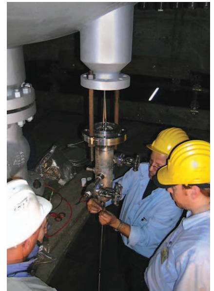
Монтаж многозонной термопары в реактор
