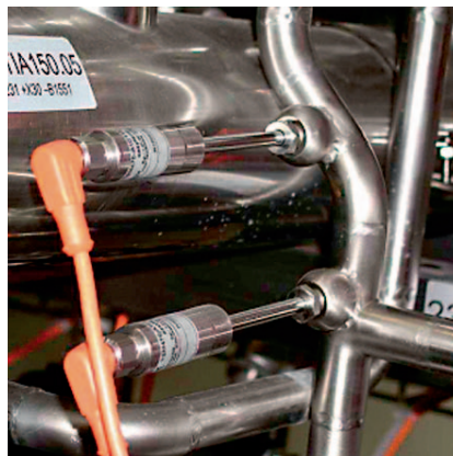
Измерение температуры в трубопровода с помощью компактных датчиков Easytemp и Thermophant
