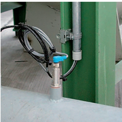
Измерение температуры в трубопровода с помощью компактных датчиков Easytemp и Thermophant
